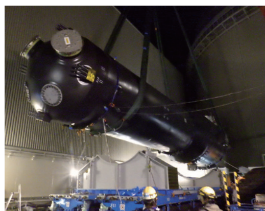
新SG吊り上げ(屋外)
